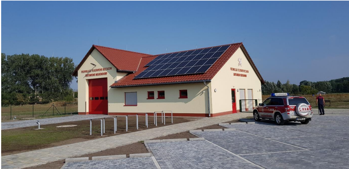
Abb. 5.3 Feuerwehrhaus Ortsfeuerwehr Neuendorf
