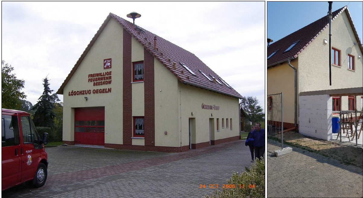
Abb. 5.4 Feuerwehrhaus Ortsfeuerwehr Oegeln
