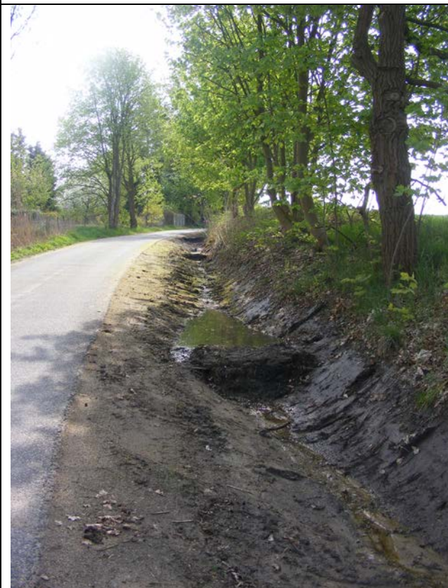
Vorhandene Regenwasserableitung „Am Mühlenberg“
