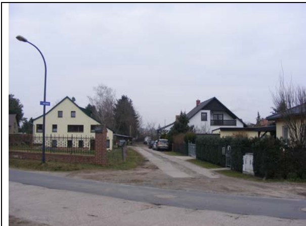
Abzweig vorderer Bereich – Befestigung der Fahrspur mit Betonplatten
