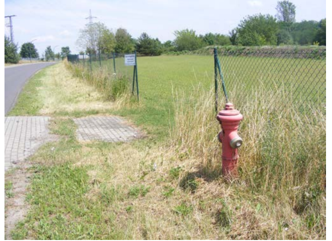
Lage Hydrant an der östlichen Zufahrt in das BP-Gebiet
