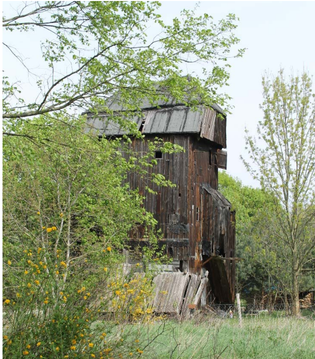
Abbildung 17: Erhaltener Korpus einer Windmühle im westlichen Zentrum des Geltungsbereiches
