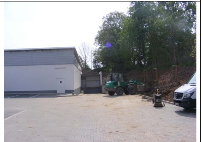
mit Anlieferungsbereich auf der Südseite
