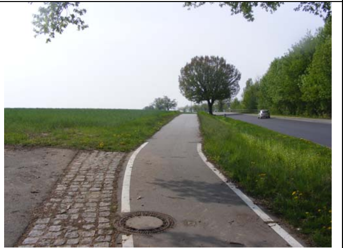
Einmündungsbereich „Am Mühlenberg“ in die B168, Blick Richtung Süden ca. in Höhe der vorgeschlagenen Haltelinie (Stoppschild)
