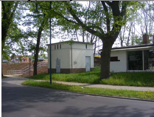
Nördlicher Bereich GEe
