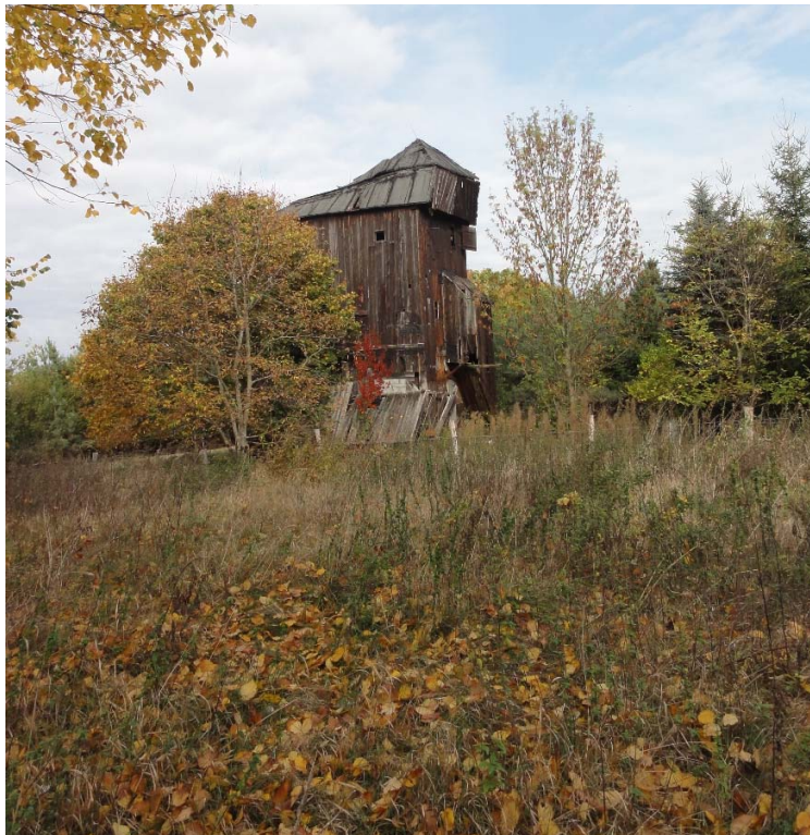
Abbildung 13: Marode Windmühle im westlichen Zentrum des Plangebietes, 19.10.2018
