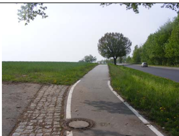
Sicht nach Süden von der Einmündung Am Mühlenberg in die B168
