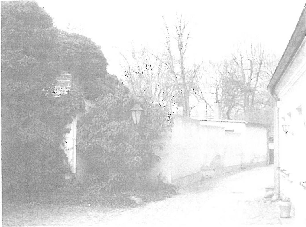
Blick aus der Mauerstraße nach Nordwest (das sichtbare Klinkermauerwerk links im Bild ist ein Teil des Weichturms in der Südecke des Grundstücks)
