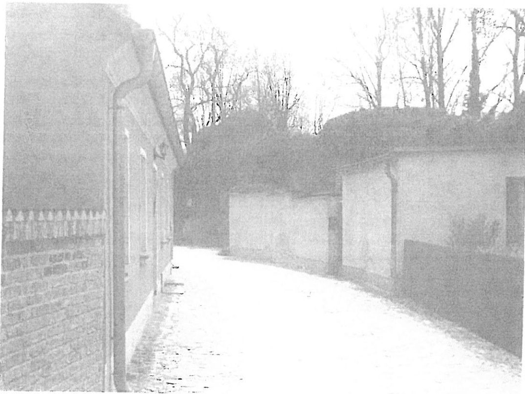
Blick aus der Mauerstraße nach Südost (ab Höhe des Werkstattgebäudes ist der Blick zum Dicken Turm möglich)
