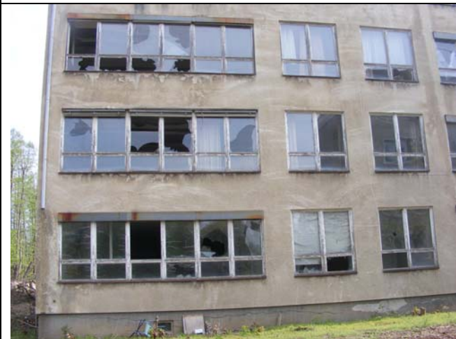
Schulungs- und Unterakunftsgebäude aus den 70er/ 80er Jahren des vergangenen Jahrhunderts
