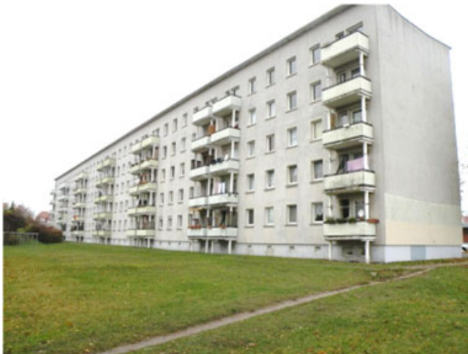
Abbildung 23: Südseite des „Bahnhofsblockes“
