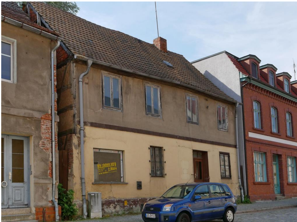
Brandstraße 38/Abbruch geplant
