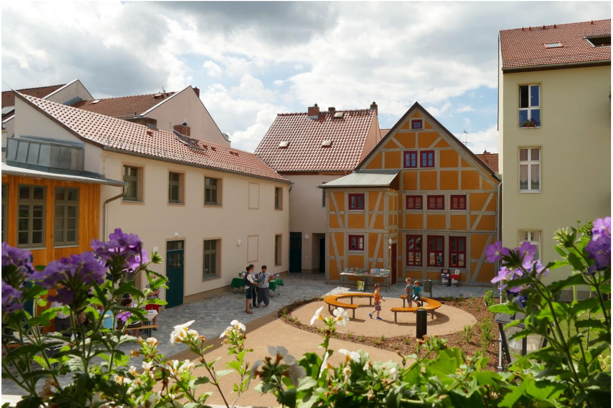
Hofbereich Berliner Straße 16
