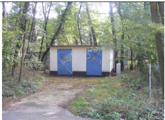
Dem Plangebiet BP W21 gegenüberliegende Bebauung – Trafostation
