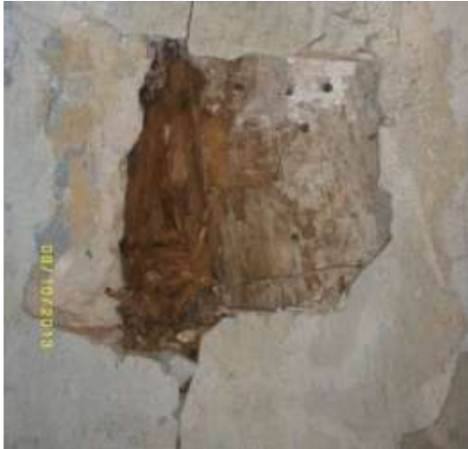
Abb. 2.4.13 Raum Nr. 18- Zimmer Hofseite/Gasse
