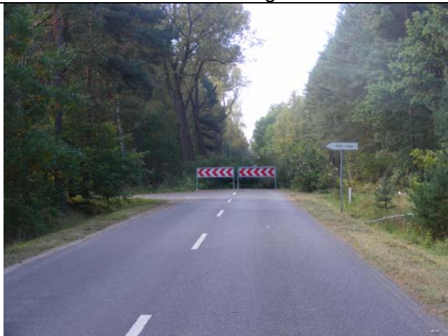
Ende der Lübbener Chaussee am Abzweig Einfahrt zum Kat-Lager
