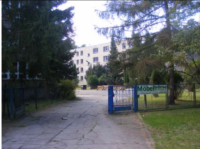
Bebauung „Möbelbörse“, östlich des Plangebietes des BP W21, in ca. 40 m Entfernung zur Plangebietsgrenze des BP
