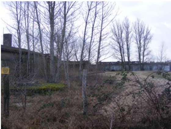
Verfallende Ställe und Gehölzbestand (durch Sukzession) südlich vom Plangebiet,
