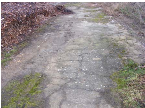
Eines der beiden verbliebenen Betonfundamente (02.2016)
