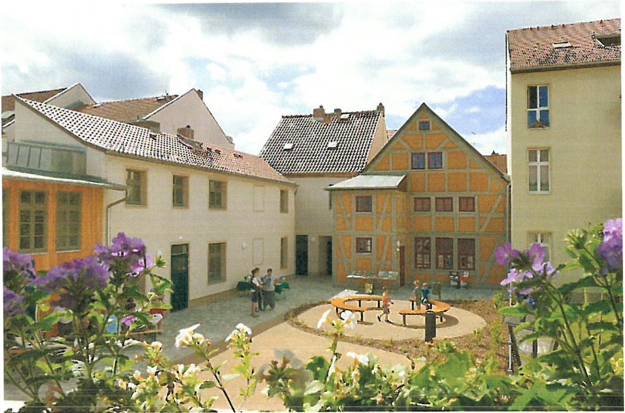
Hofbereich Berliner Straße 16
