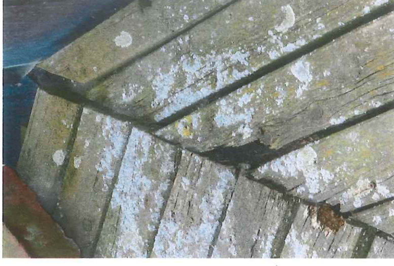
Beschädigte Lattenroste
