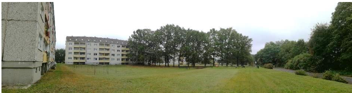
Abbildung 25: Bebauung und Baumgruppe in den Teilflächen 2 und 3
