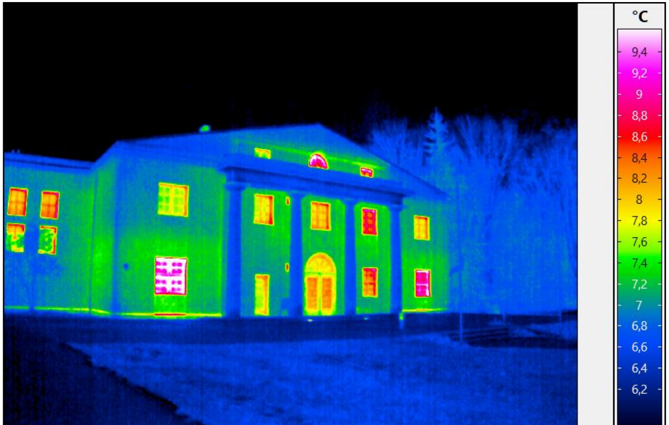
Abbildung 7: Thermografieaufnahme Alte Turnhalle
