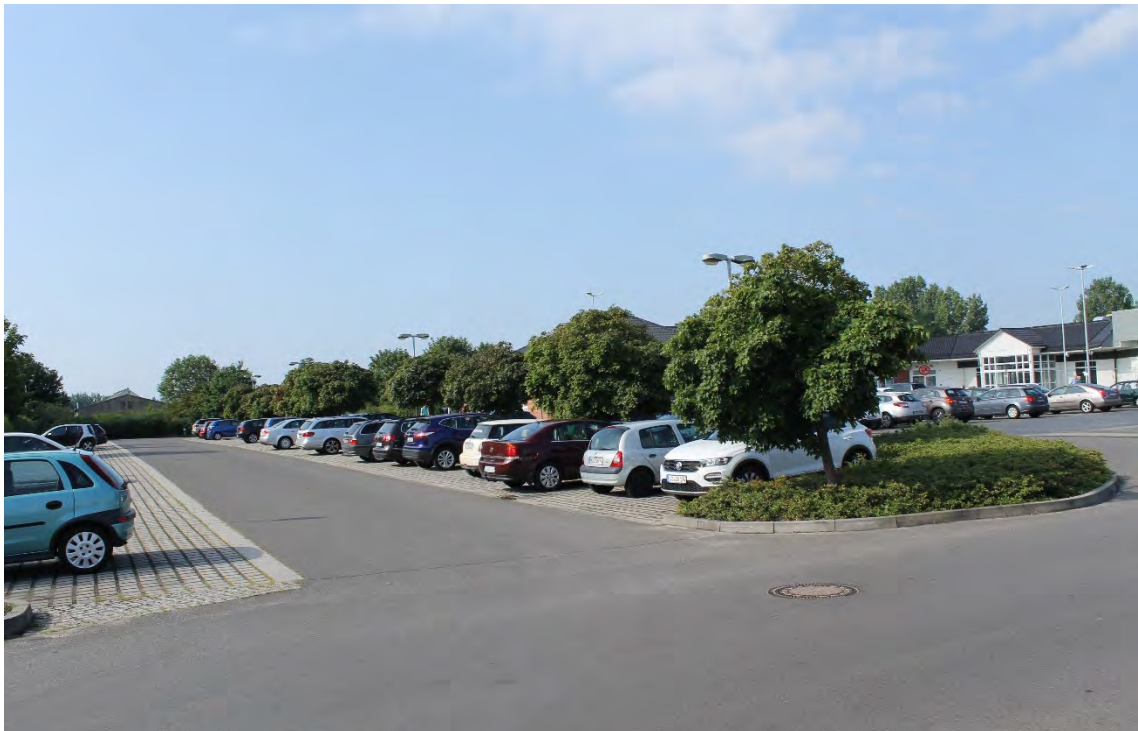
Abbildung 3: Dem Hauptgebäudekomplex des Einkaufszentrums vorgelagerter Parkplatzbereich mit asphaltierten Fahrwegen, teilversiegelten Stellflächen, Kriechmispeldickicht und Kugelahornen
