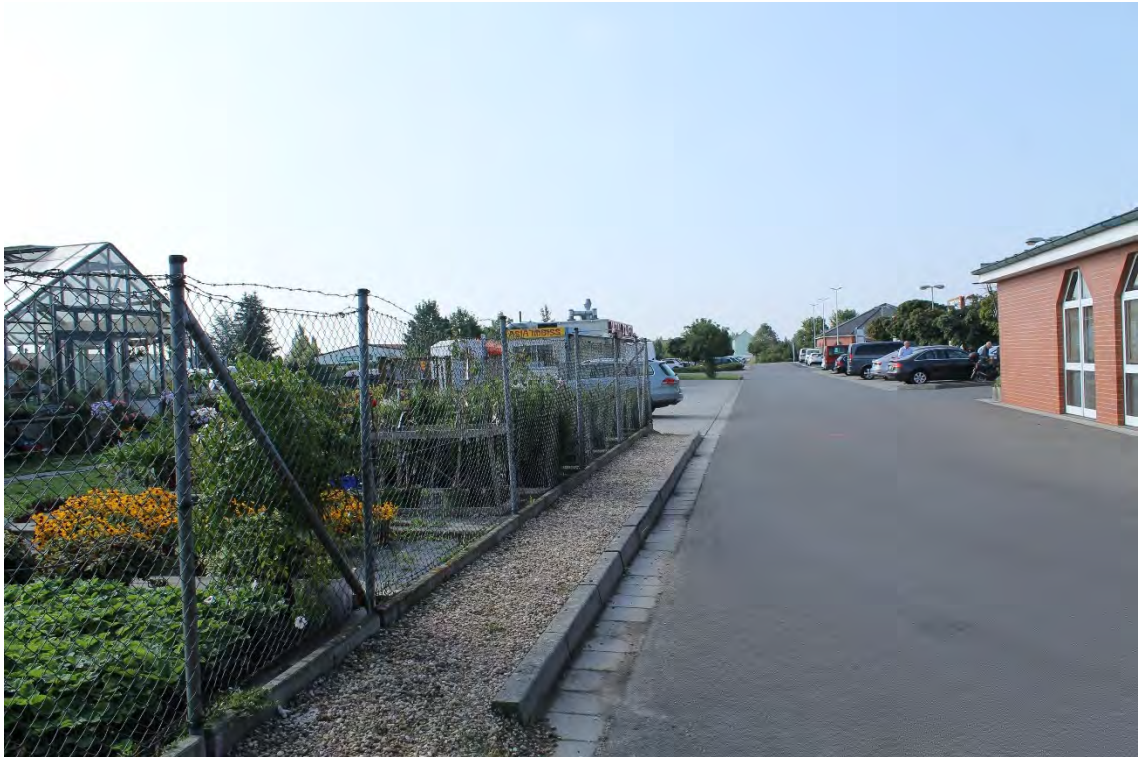
Abbildung 6: Ausgehend von der B168 dem Hauptgebäudekomplex vorgelagerte Gewerbestandorte - Bereich m. asphaltierter Fahrbahn, Gärtnerei (m. Gewächshaus und Freilandbereich), Gebäuden und Parkplätzen
