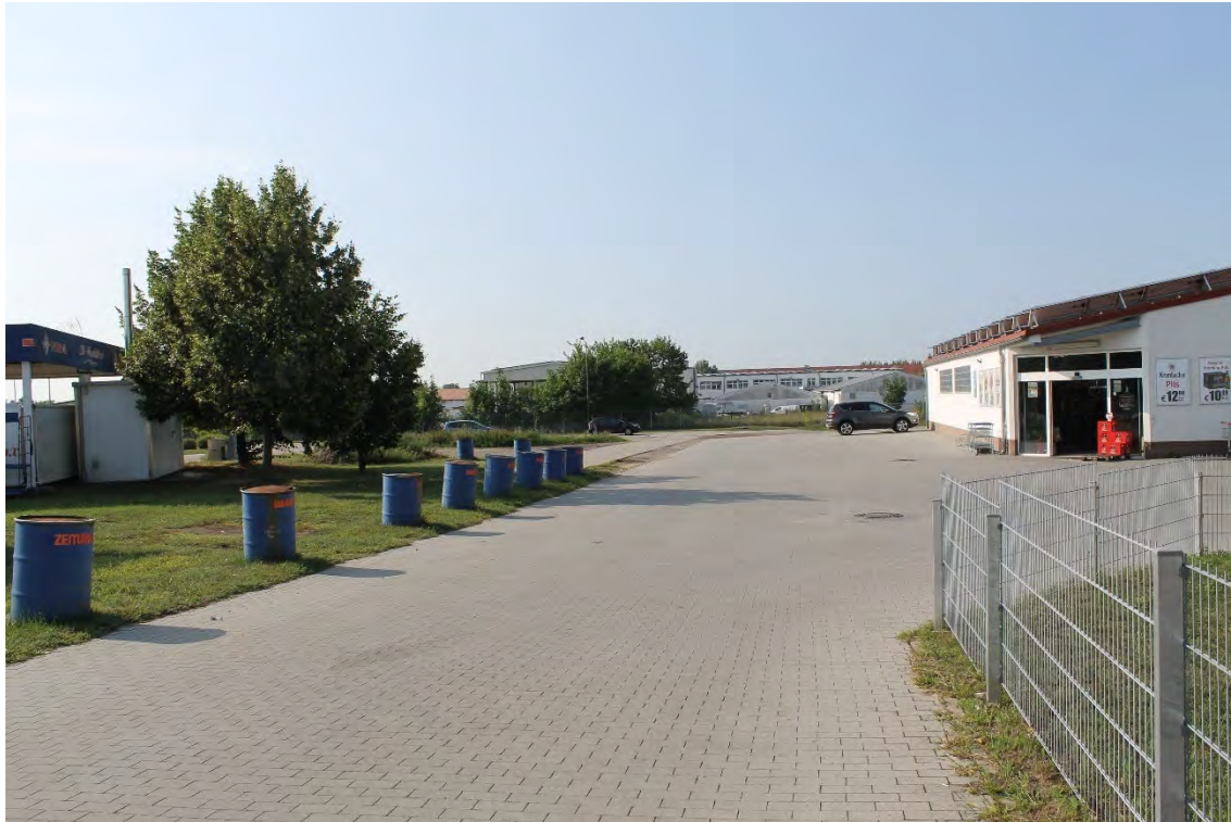
Abbildung 4: Ausgehend von der B168 dem Hauptgebäudekomplex vorgelagerte Gewerbestandorte, Fahrwege und Grünflächen (hier: Vielschnittrasen um Tankstelle m. einzelnen Linden)
