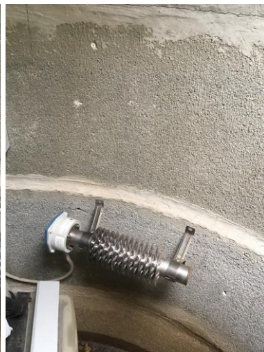
Bild 12 - Elektroheizung
