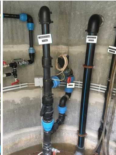
Bild 6 – Saug / Druckleitung
