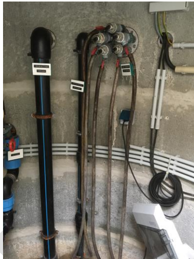
Bild 8 - Kabeldurchführungen
