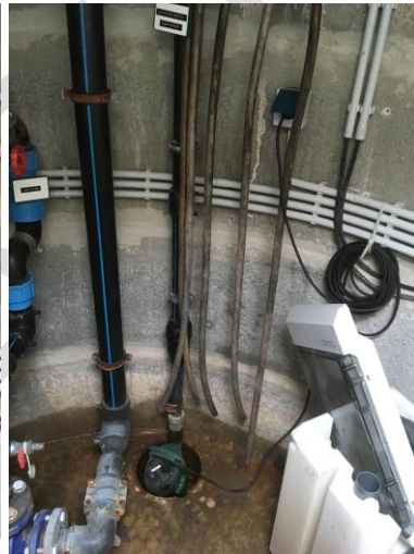
Bild 9 - Hebeanlage
