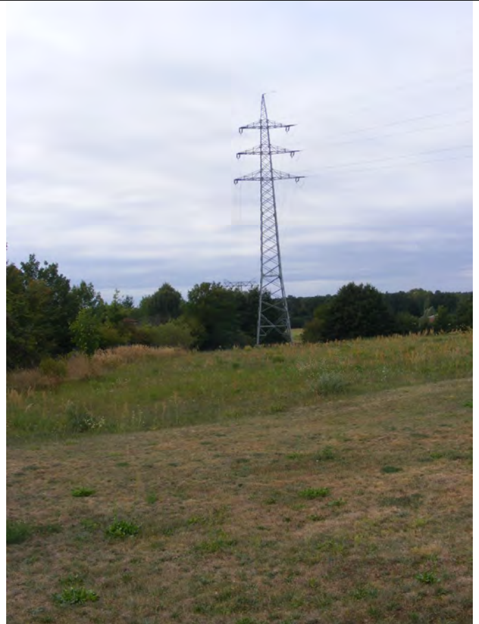
Die das Plangebiet querende 110kV-Leitung mit dem prägenden Stahlgittermast im nordwestlichen Plangebietsbereich
