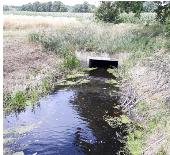
Abb. 4: Oelse - Durchlass im östlichen Geltungsbereich
