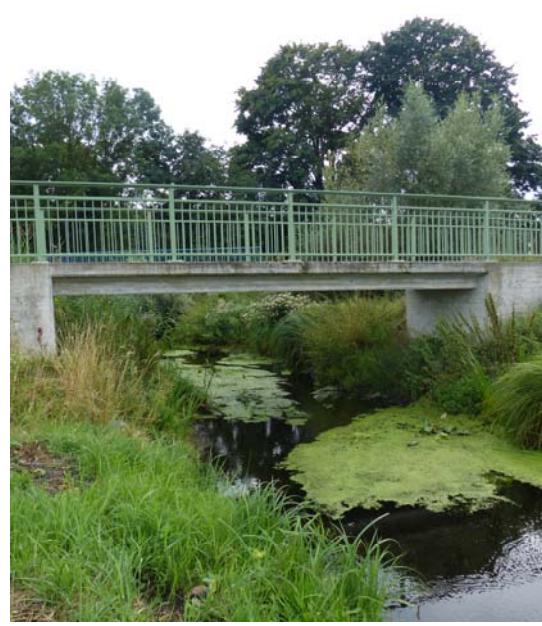
Abb. 15: B 246 - Radwegüberführung der Oelse
