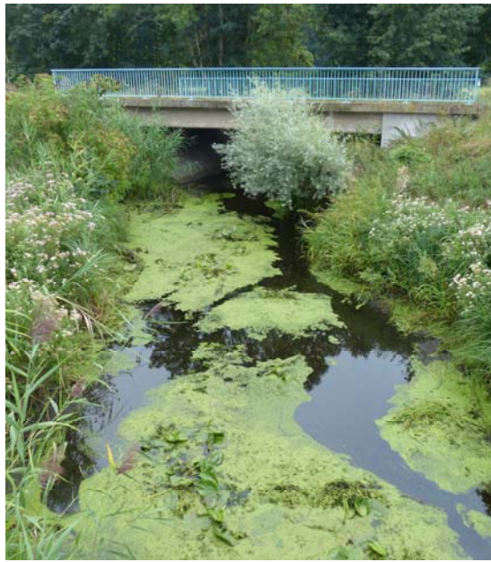
Abb. 14: B 246 - Straßenüberführung der Oelse
